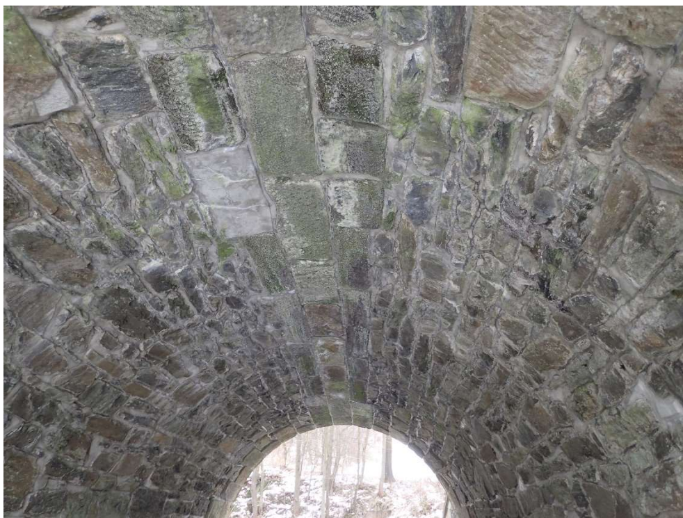
Foto 4: Průsaky, degradace kamene, trhliny v klenbě
