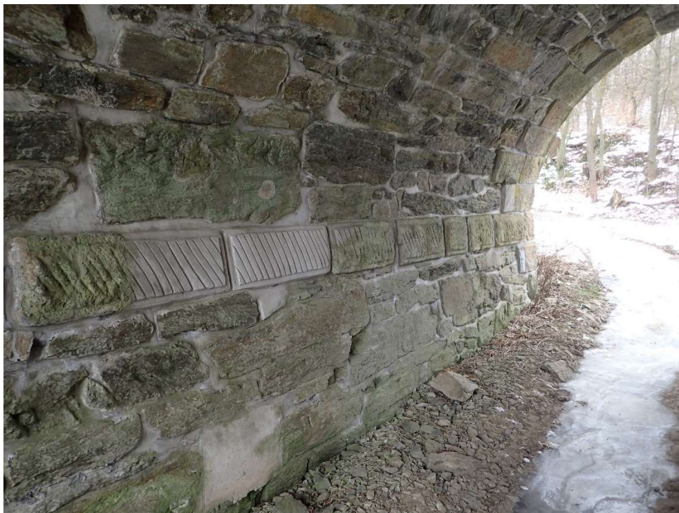
Foto 3: Místy vypadané a popraskané spárování
