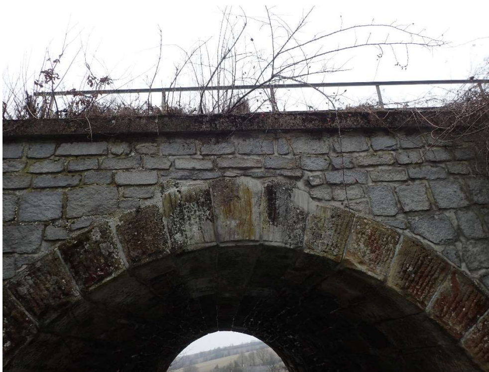
Foto 5: Římsy čelních zídek porušeny trhlinami
